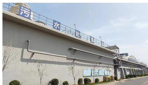
际华 3542 公司污水处理站
