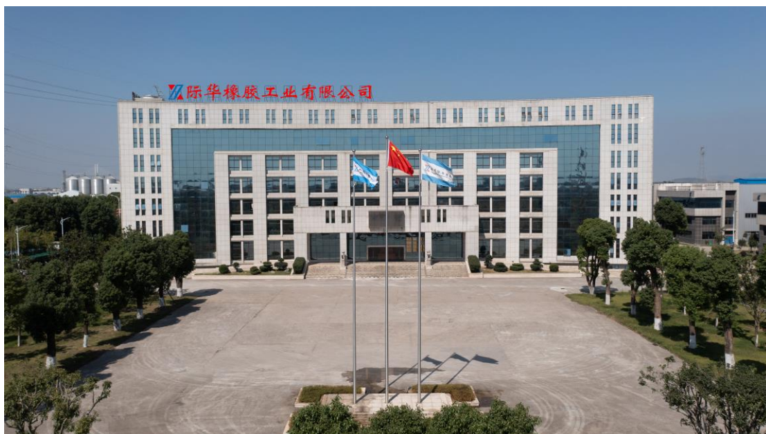
际华橡胶工业有限公司绿色工厂厂区
