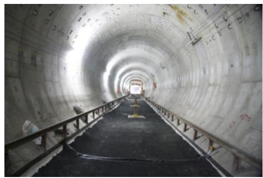
隔离式橡胶减振垫使用效果图
