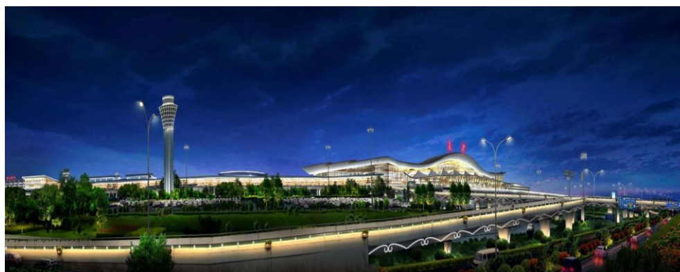
长沙一点两线及人民东路景观亮化工程
